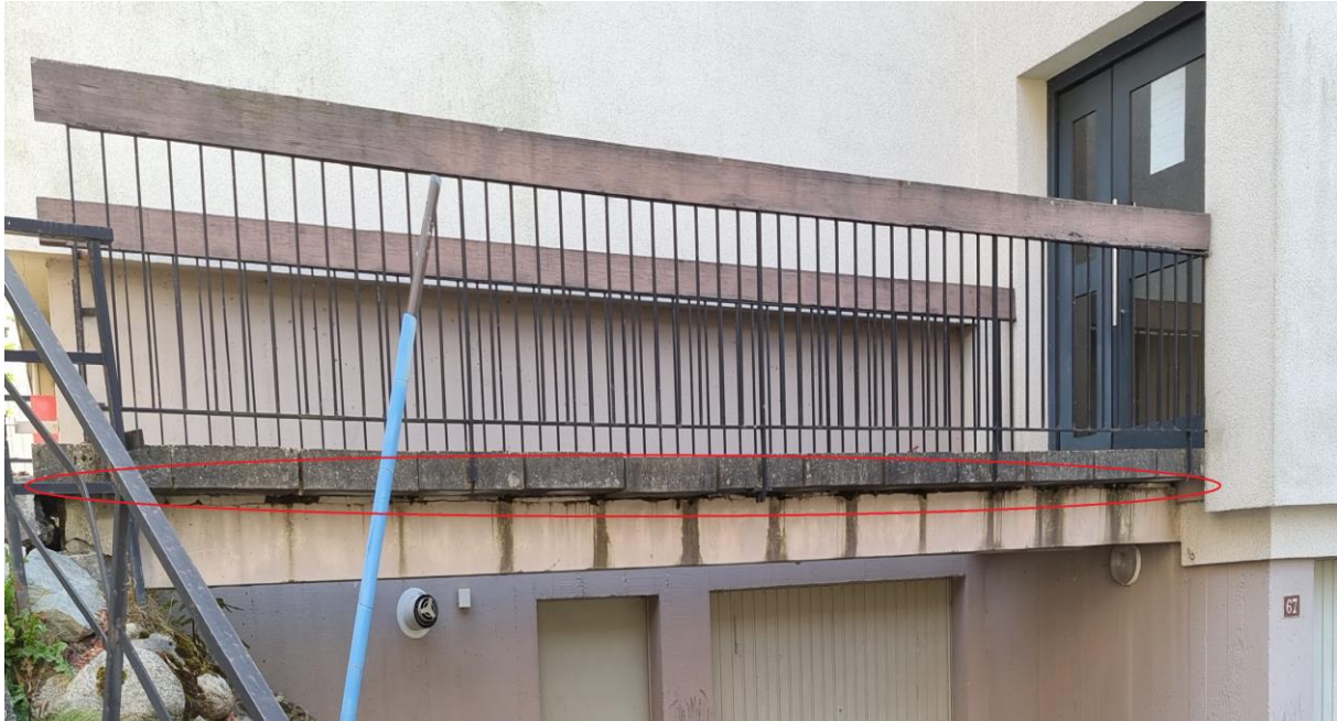
Effritements en tête de poutres
