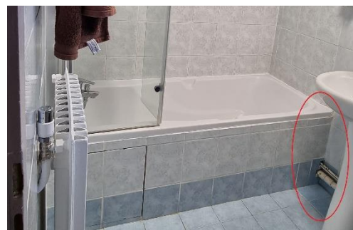
Exemple appartement bâtiment A (tablier à démolir pour remplacement réseau)
