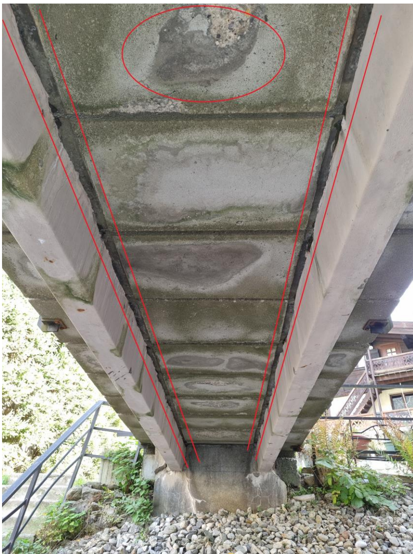
Effritements en tête de poutres et en sous-face de tablier
