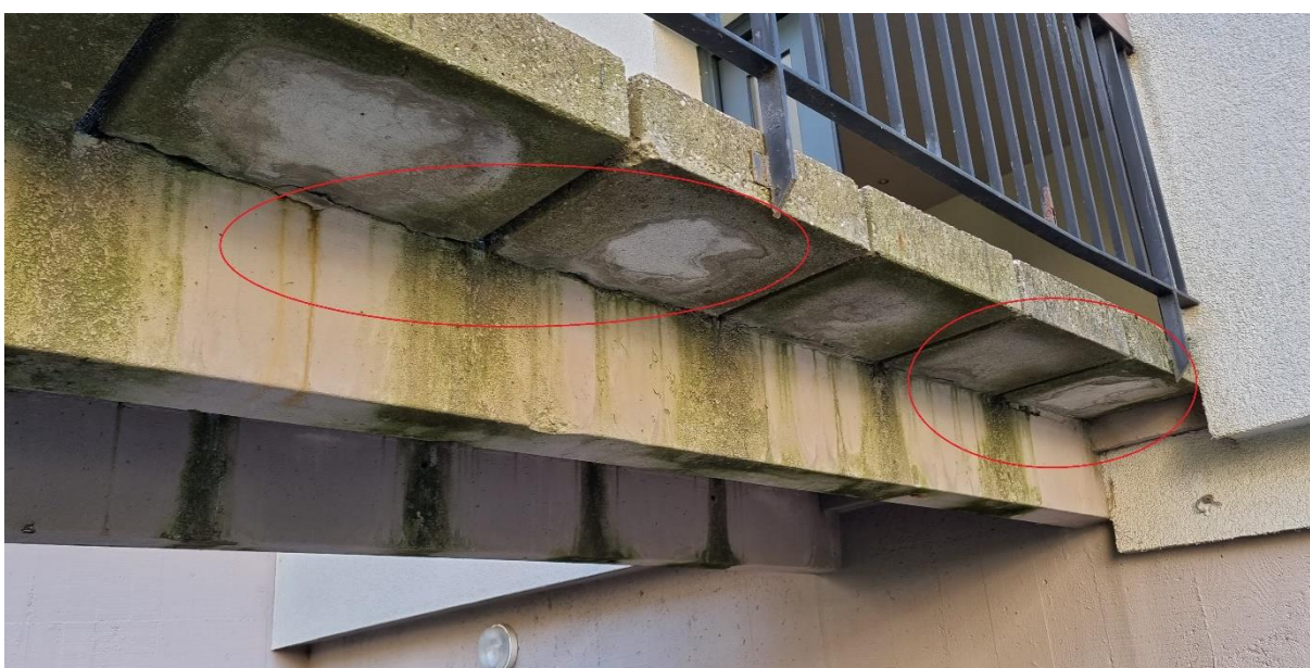
Effritement en tête de poutre et sous-face de tablier
