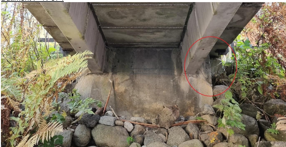
Fissuration en tête de pilier
