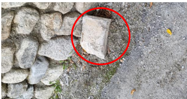
Bloc de béton appartenant à la structure de la passerelle tombé au sol
