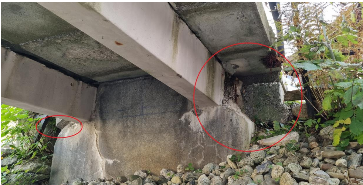
Désolidarisation de blocs de béton et aciers apparents en tête de pilier
