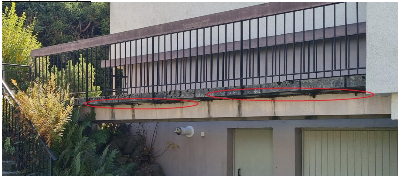
Effritements en tête de poutres
