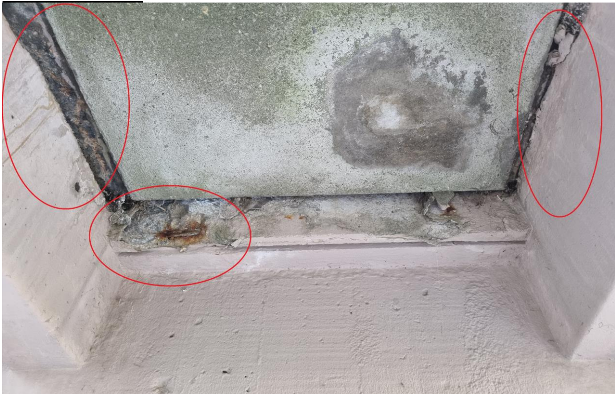
Effritements en tête de poutres et aciers apparents
