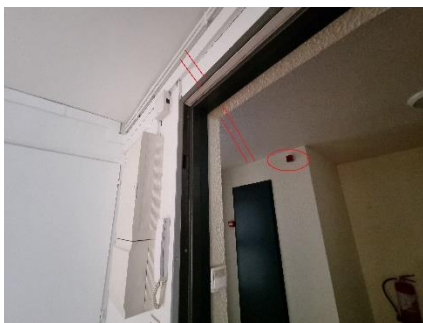
Exemple appartement RDC bâtiment B (passage en apparent, cellule et goulottes)
