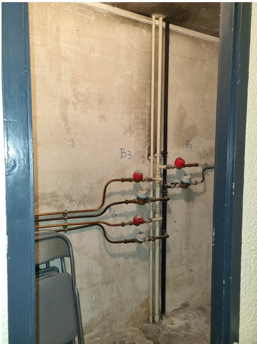
Sous-compteurs placard technique bâtiment B
